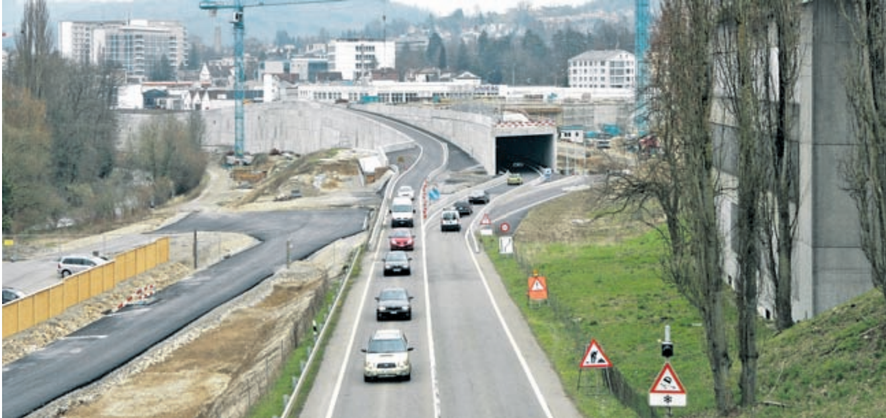
Neubaustrecke bei Liestal. Die Hauptursache für die Kostenexplosion ist laut einer Expertise die Bauteuerung während der langen Planungszeit. Foto Henry Muchenberger
