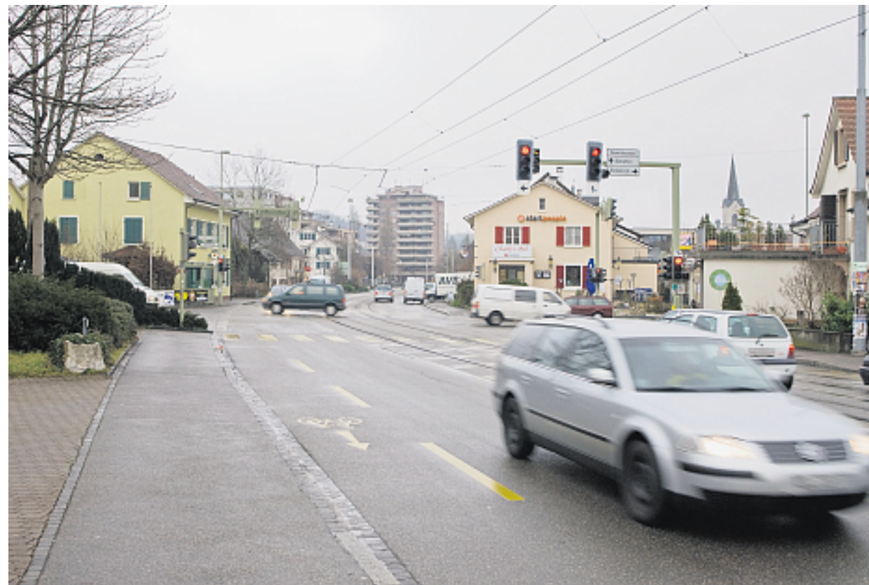
Viel Verkehr. Die Kreuzung Hauptstrasse/Bruggstrasse wird zu einem Kreisel umgebaut. Foto Daniel Desborough
