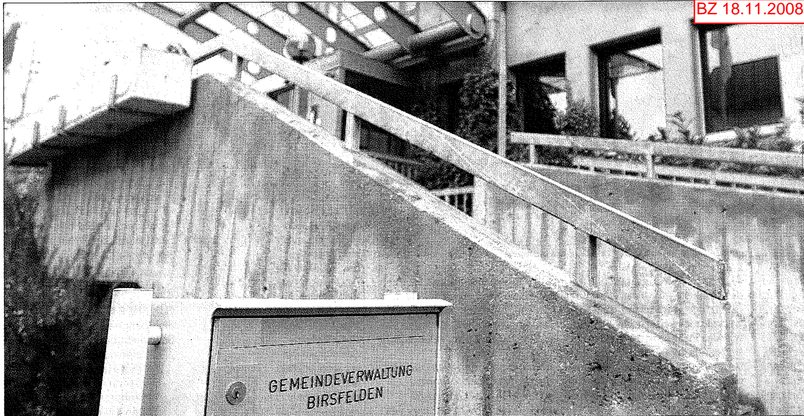
NEUE STUFE Gemeinderat und Verwaltung bemühen sich, die Birsfelder Bevölkerung aktiver zu informieren über Ereignisse und Beschlüsse. HEINZ DÜRRENBERGER
